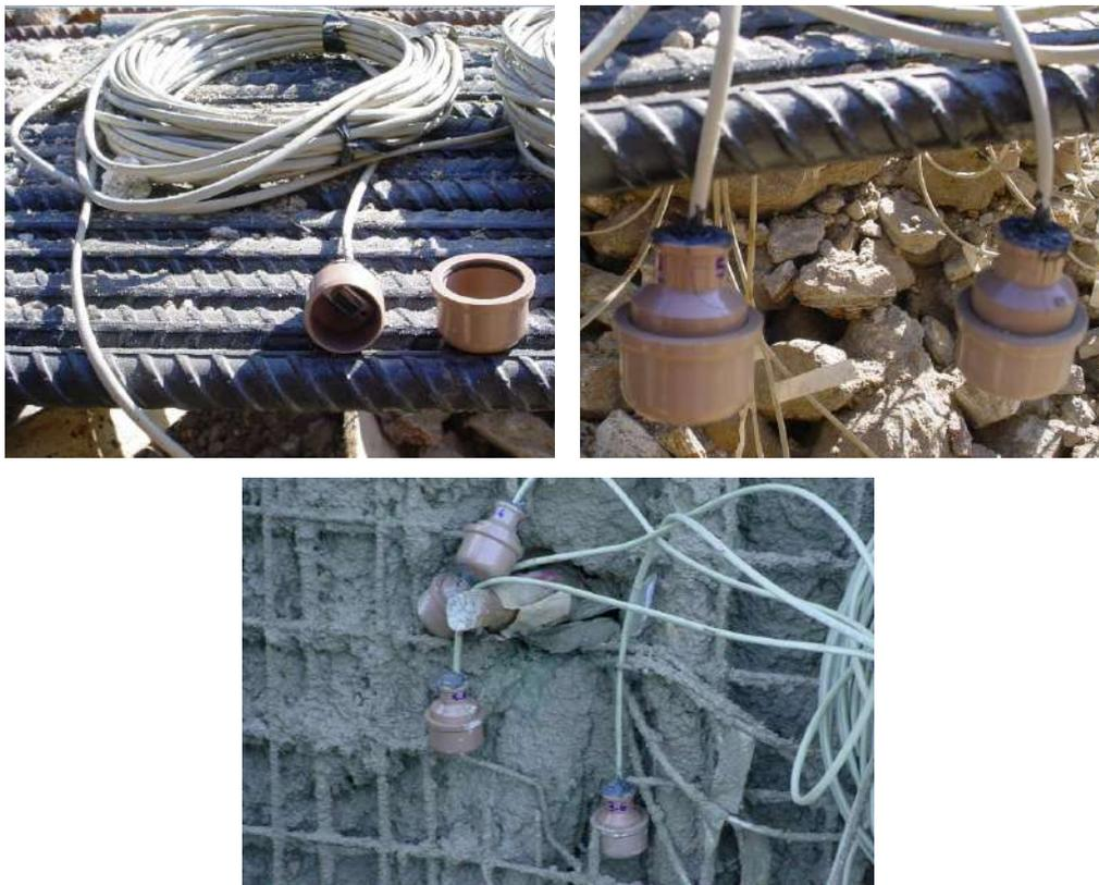
Figura V.17 – Conectores e terminais protegidos por meio de caixas “blindadas”.
