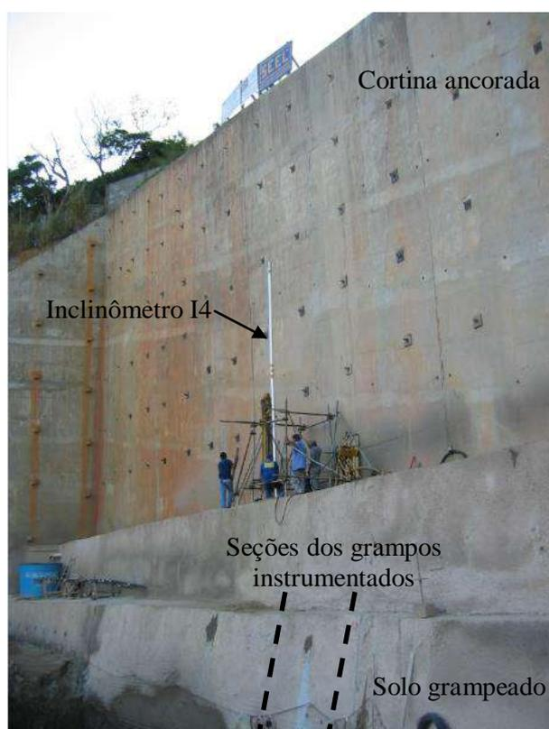
Figura VI.12 – Instalação do tubo de acesso ranhurado referente à vertical inclinométrica I4, adjacente à seção dos grampos instrumentados com *strain gages*.
