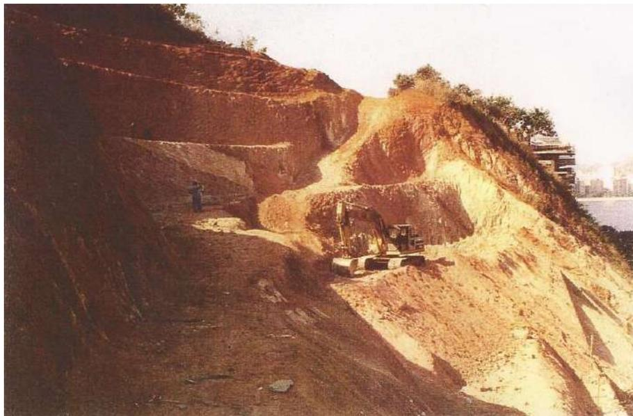
Figura VI.4 – Retaludamento do terreno a montante da cortina ancorada.
