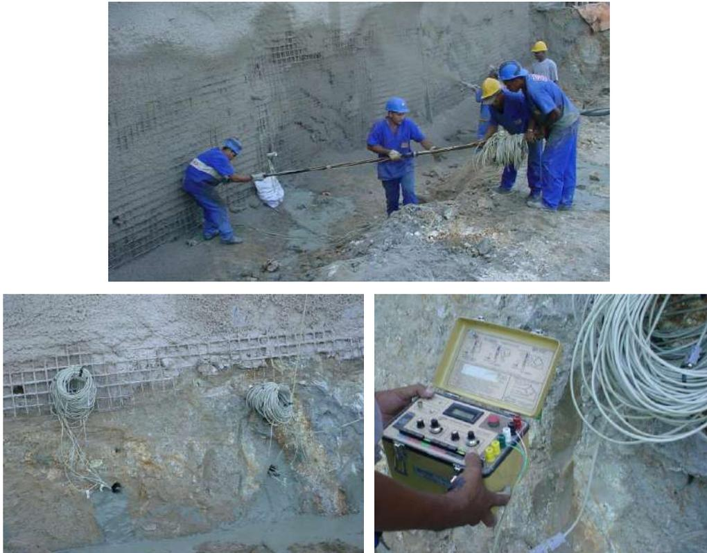
Figura VI.21 – Etapas da instalação das barras: (a) colocação da barra instrumentada no furo pré-aberto; (b) situação logo após injeção de calda de cimento (c) realização da leitura inicial.
