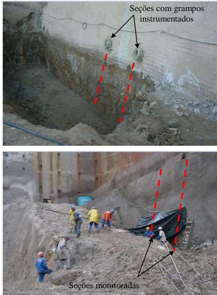
Figura VI.14 – Locação das seções monitoradas com grampos instrumentados.
