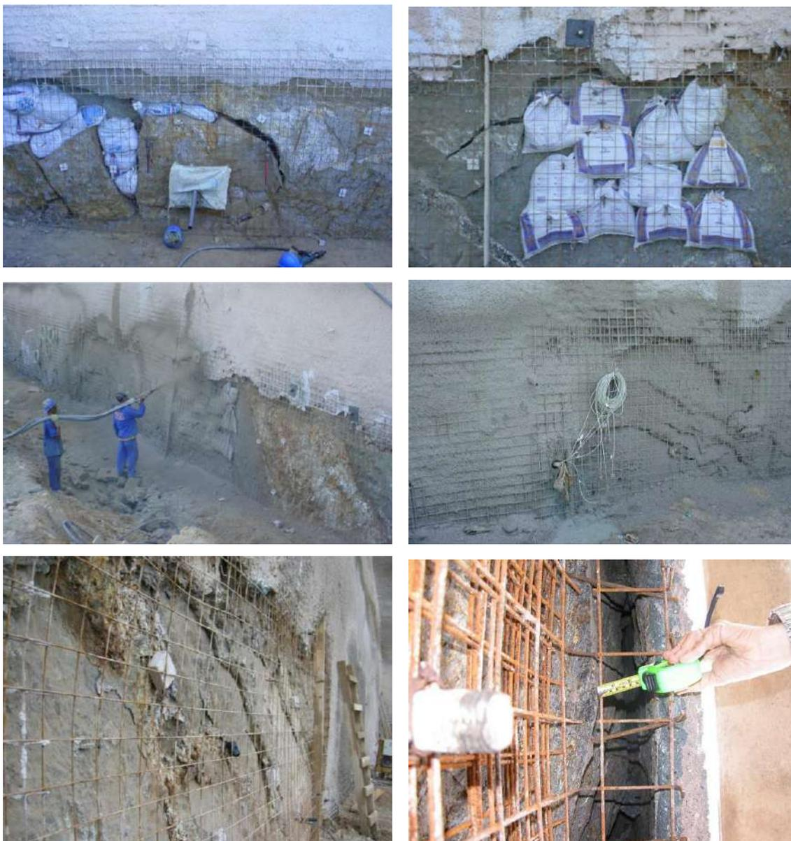
Figura VIII.13 – Rupturas localizadas na face da escavação.
