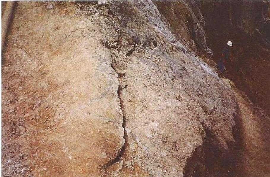
Figura VI.3 – Aparecimento de trinca na encosta a montante da cortina ancorada.
