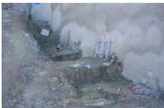
Figura VIII.12 – Processo executivo da escavação em solo grampeado.
